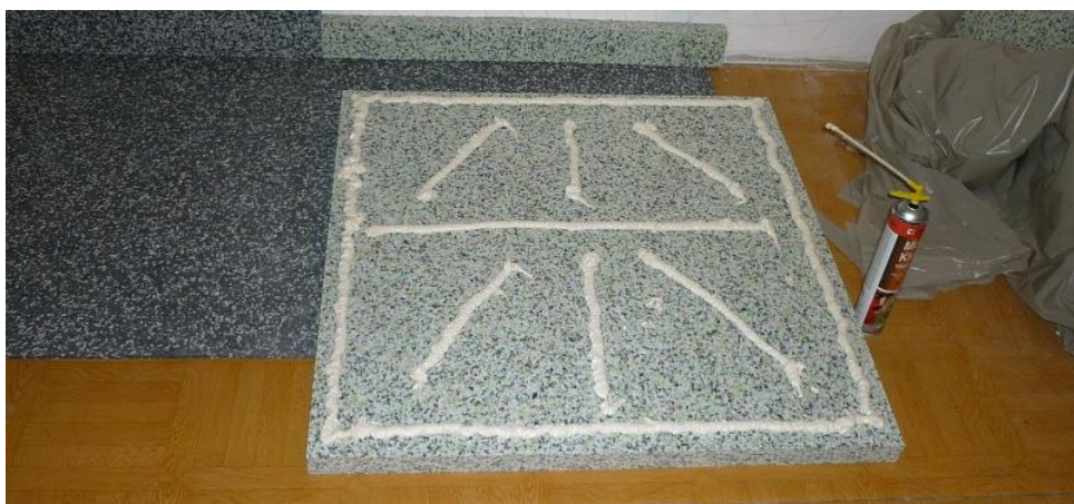
Obrázek 8: Zvuková izolace z lisovaných desek
