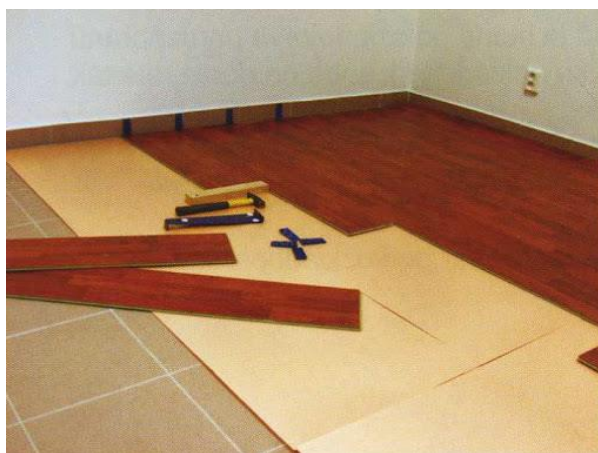
Obrázek 14: Montáž podložky STARLON
