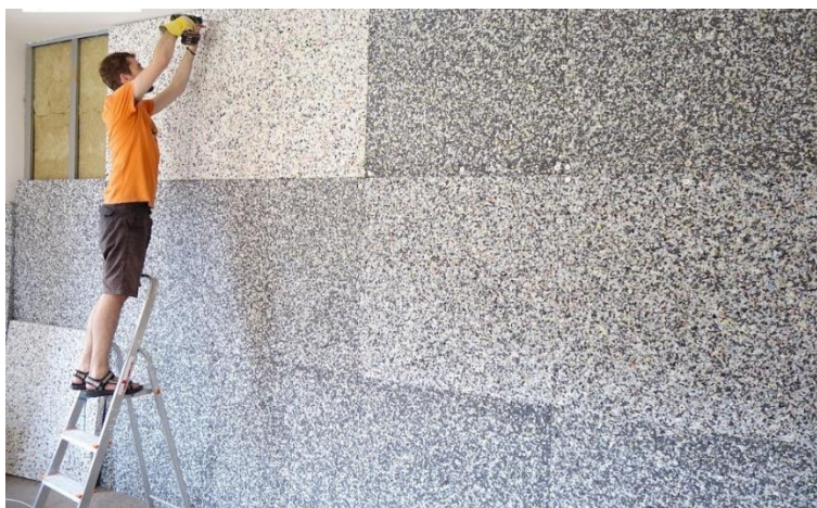
Obrázek 9: Způsob lepení lisovaných desek
